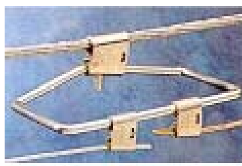
Figura 4 – Ramais conectados ao estribo
