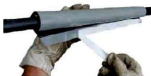
Figura 1 – Emenda para conexão por compressão Figura 2 – Manta para cobertura de cabos 35kV
