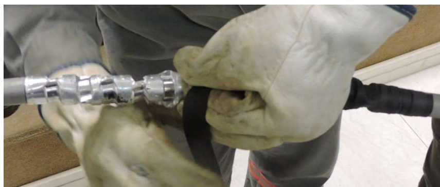
Figura 15 – Aplicação de fita de autofusão
