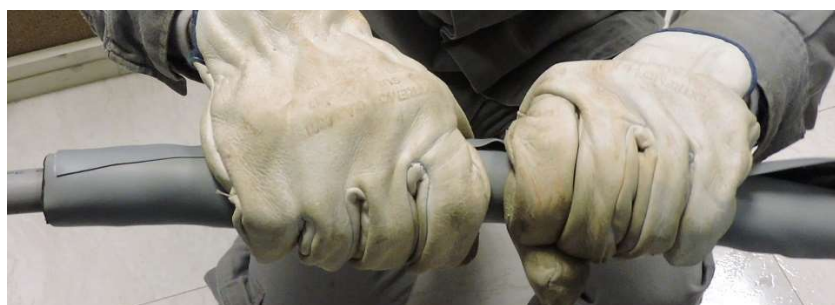
Figura 21 – Aplicação da manta para cobertura
