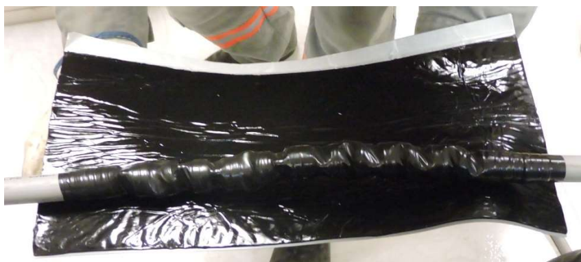
Figura 19 – Aplicação da manta para cobertura
