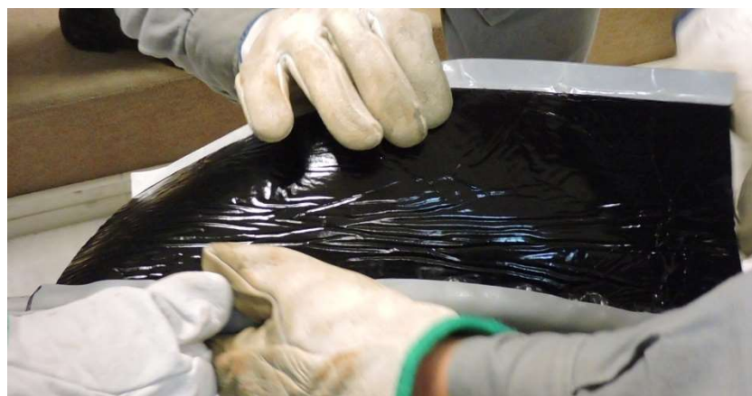
Figura 20 – Aplicação da manta para cobertura
