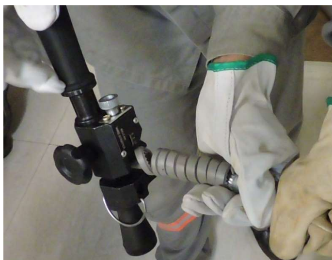
Figura 9 – Retirando a cobertura – término
