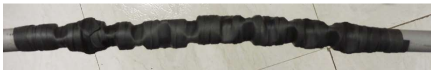
Figura 16 – Emenda com fita de autofusão pronta
