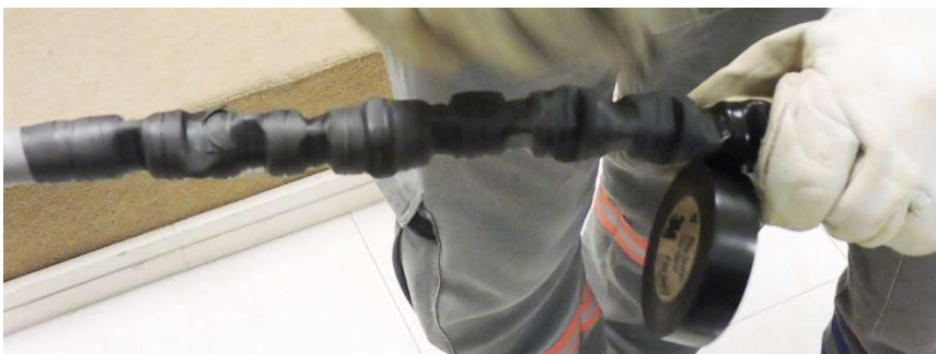
Figura 17 – Aplicação de fita isolante
